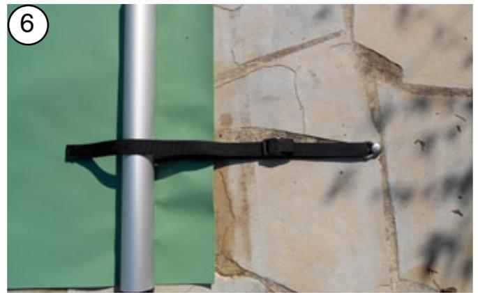
Accrocher les anneaux d'extrémité des sangles de tension à leurs pitons respectifs. Vérifier et régler au moyen des sangles le parallélisme de la barre par rapport au mur de la piscine.
