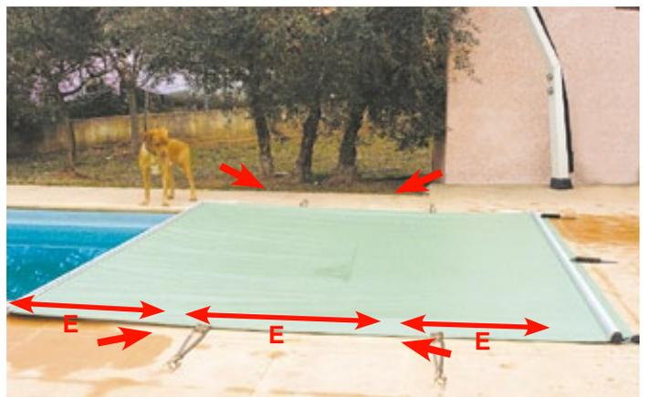
Tracer sur la plage l'emplacement des 3 pitons à douille destinés au maintien des sangles de tension d'escalier suivant le plan ci-dessus.
