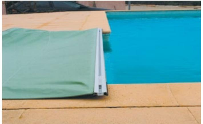
Placer l'élément séparé de la couverture au-dessus de l'escalier. L'axe du profil de remplacement de margelle devra être à 10 cm de la paroi intérieure de la piscine (schéma ci-dessus). Vérifier également que les côtes "D" soient identiques pour que le profil soit bien en prolongement des margelles.
