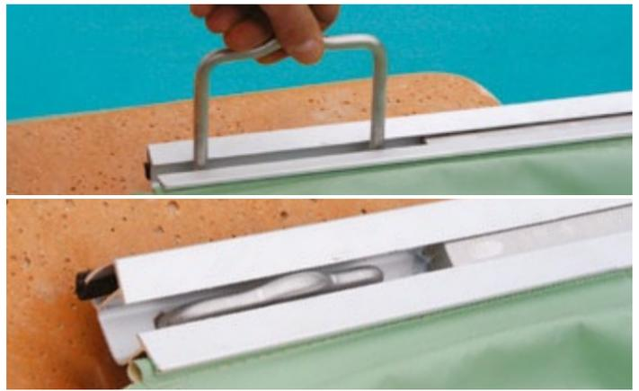
Utiliser le profil de remplacement de margelle comme gabarit pour percer à chaque extrémité les deux trous  $\varnothing 10$  mm dans la margelle. Insérer un cavalier de blocage à chaque extrémité du profil pour le fixer sur les margelles.
