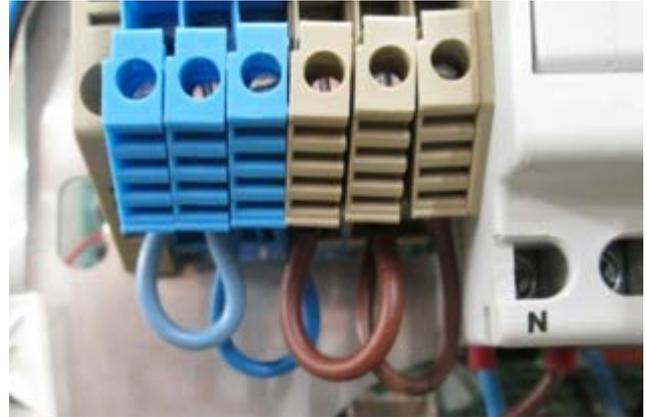
**6.** Raccorder les fils 21 et 22 sur la borne de neutre en veillant à respecter le passage des fils qui sont déjà en place. Voir l'exemple ci-contre, mais la configuration peut différer en fonction du type de pompe à chaleur.
