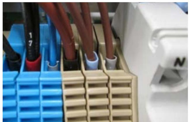
La partie supérieure du relais offre la possibilité de raccorder plusieurs contacts normalement ouverts et normalement fermés. Dans notre cas, un contact normalement ouvert sera utilisé (par exemple 9/11 et 5/14). Ce contact doit permettre d'asservir le contacteur de la pompe de filtration à la pompe à chaleur. **Important, ne pas raccorder directement la pompe de filtration à ce contact. Il est impératif d'utiliser ce contact pour commander le contacteur dédié à la filtration.**
