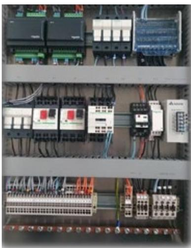
Au moins une fois par an, il sera procédé à la vérification des connexions, au nettoyage des contacts et aux essais de sécurité.
