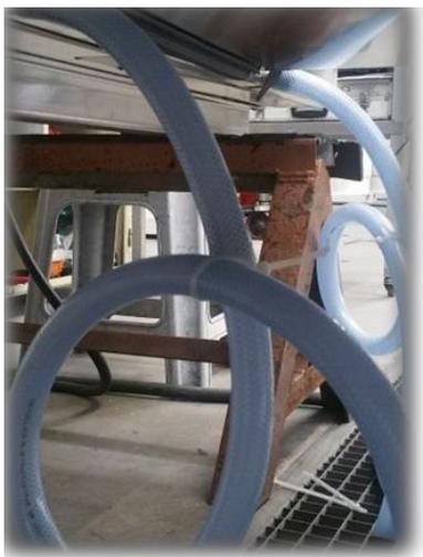
Le bac de réception ainsi que les orifices d'évacuation et les siphons seront débarrassés des dépôts, boues ou poussières qui risqueraient d'obstruer l'écoulement normal des condensats ou infiltrations naturelles.
