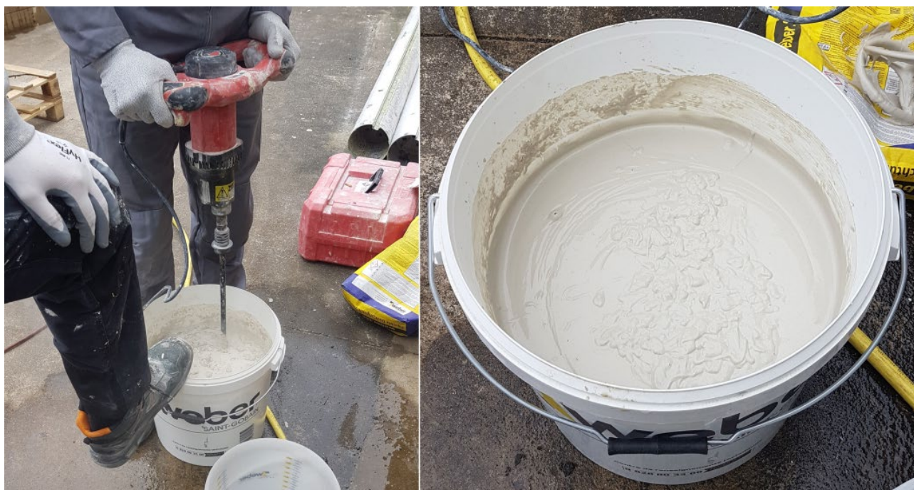
Figure 12 : Mélange d'enduit d'étanchéité
